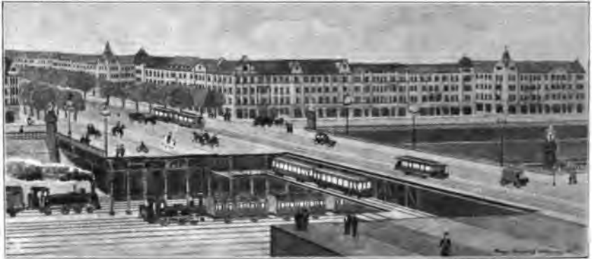
Abb. 149. Die Bismarck-Straßenbrücke mit Straßen- und Untergrundbahn über die Ringbahn.
